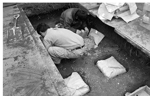
『D-BOX』工法による地盤改良工事のようす
