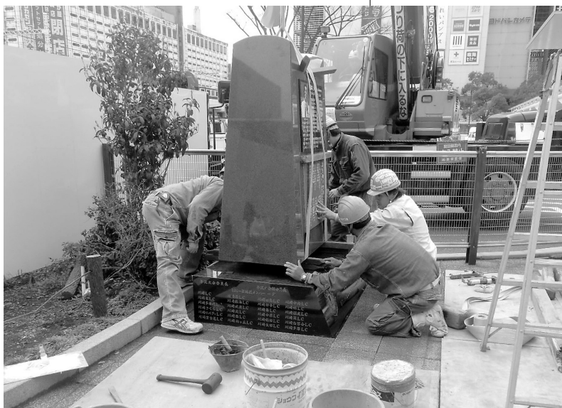
同社による記念碑の設置作業の様子
