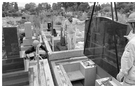
クレーンを使った墓地での施工作業のようす
