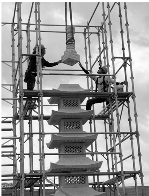
足場を組んで行なった五重塔の施工のようす（東京都内某所）。墓石以外の灯籠や石仏、鳥居、記念碑などの建て込み作業も請け負う
